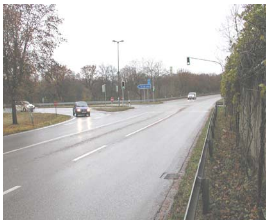
Bild 1: Pasinger Straße nördlich mit Blick auf Kreuzungsbereich samt freilaufendem Rechtsabbiegestreifen; Zustand vor Maßnahmenumsetzung
