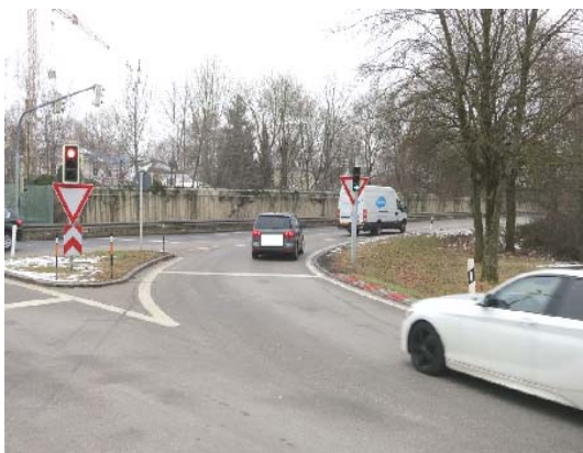
Bild 3: Blick auf den nun in die Signalisierung einbezogenen vormals freilaufenden Rechtsabbiegestreifen
