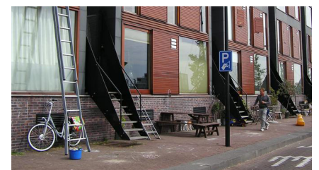
Abb. 35, Eingangsbereiche EG-Wohnungen: Borneokade 315-325, Amsterdam (NL)
