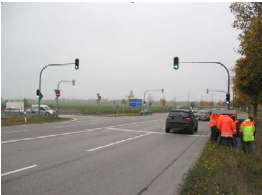
Bild 1: B 2 östlich (Richtung München) mit Blick auf den östlichen Knotenbereich; Zustand vor Maßnahmenumsetzung
