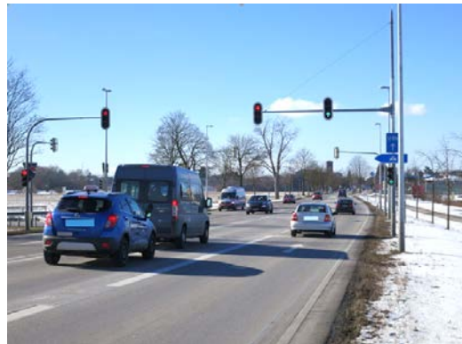
Bild 4: B 2 westlich (Richtung Germering) mit Blick auf den westlichen Knotenbereich; Zustand nach Maßnahmenumsetzung
