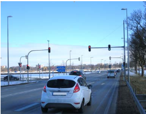
Bild 2: B 2 östlich (Richtung München) mit Blick auf den östlichen Knotenbereich; Zustand nach Maßnahmenumsetzung
