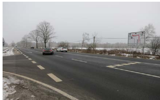
Bild 4: B 471 östlich mit Blick auf den Einmündungsbereich mit der Baderstraße; Zustand nach Maßnahmenumsetzung
