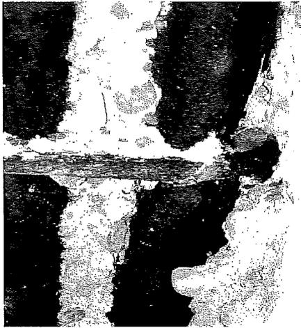
Korrodierte, freiliegende Bewehrungen
