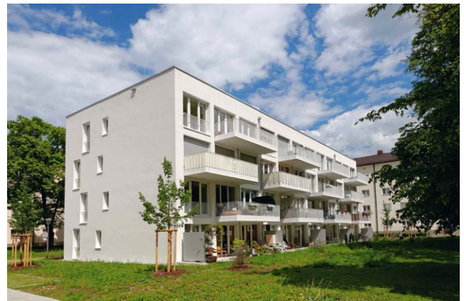
Die Passivhäuser der GEWOFAG am Piusplatz wurden mit dem Deutschen Bauherrenpreis ausgezeichnet und mit dem Kommunalen Wohnungsbauprogramm B gefördert.
