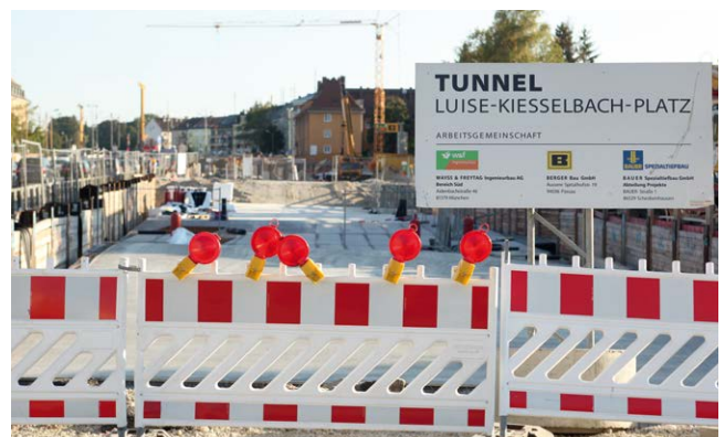
Tunnelbau Mittlerer Ring Südwest
