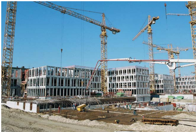
Wohnungsbau in München
