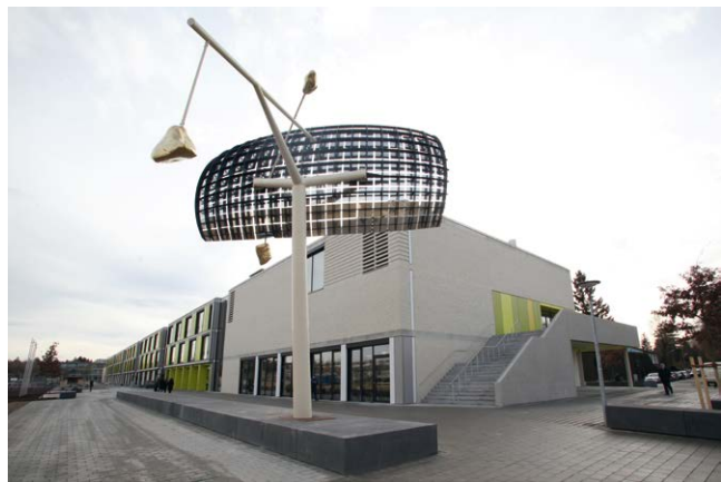
Das Gymnasium in Trudering wurde im Januar 2014 eröffnet
