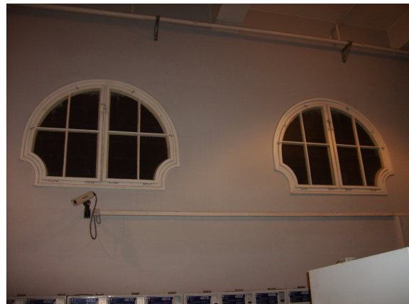
Fenster Südtrakt (Foto: privat)
