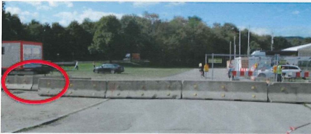
Betonsperrendurchgang mit Überlappung links im Schotter und Parkbereich
