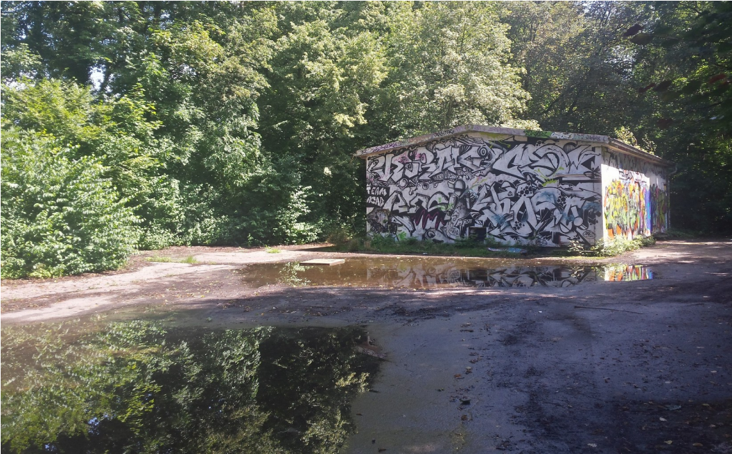
Baufeld im Bürgerpark Oberföhring mit noch abzureißenden Hallen des alten Luftwaffenlazarets.
