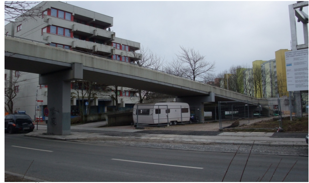
Ein Übergang für den Fuß- und Radverkehr
