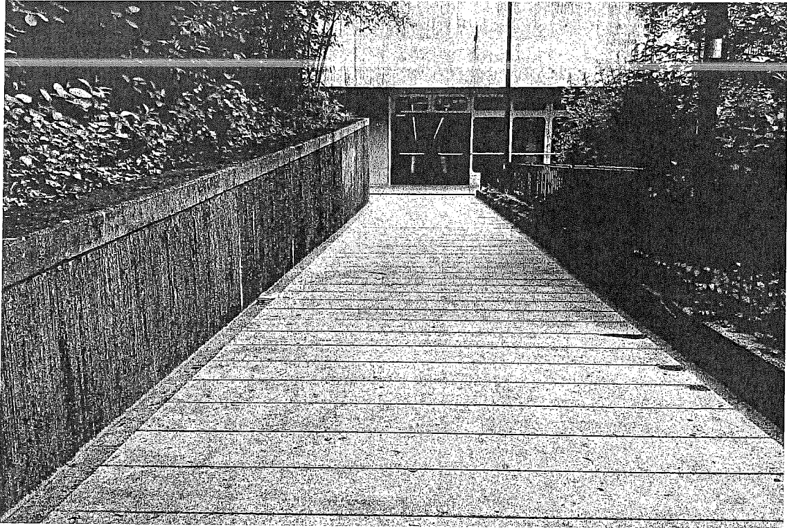
Bestehende Erschließungsrampe mit Eingangstür in das Sperrengeschoss.
