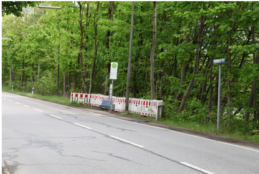
Bushaltestelle „Schwarzwaldstraße“ Richtung Zamilapark
