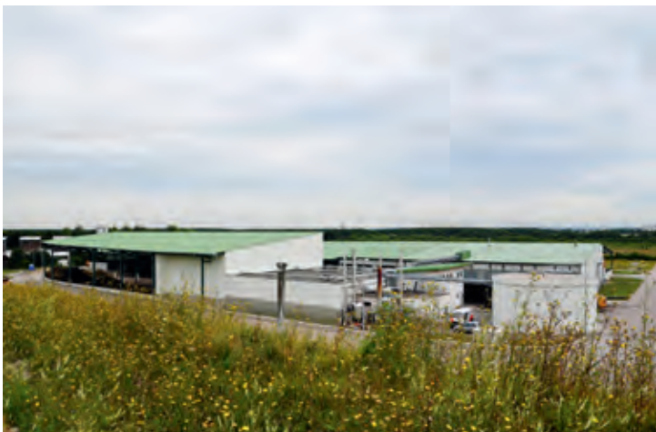
Die Trockenfermentationsanlage des AWM
