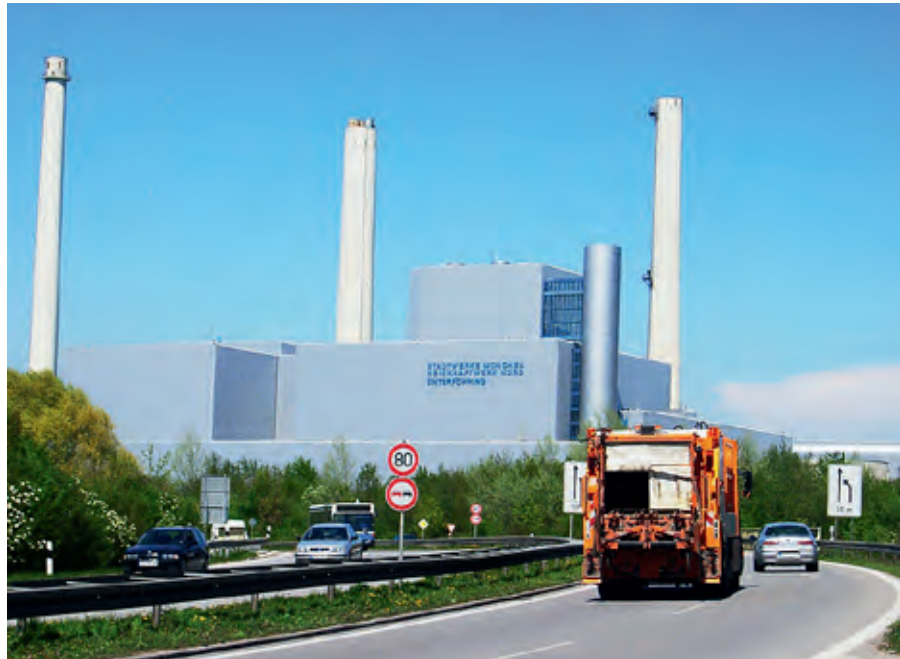
Heizkraftwerk Nord der SWM
