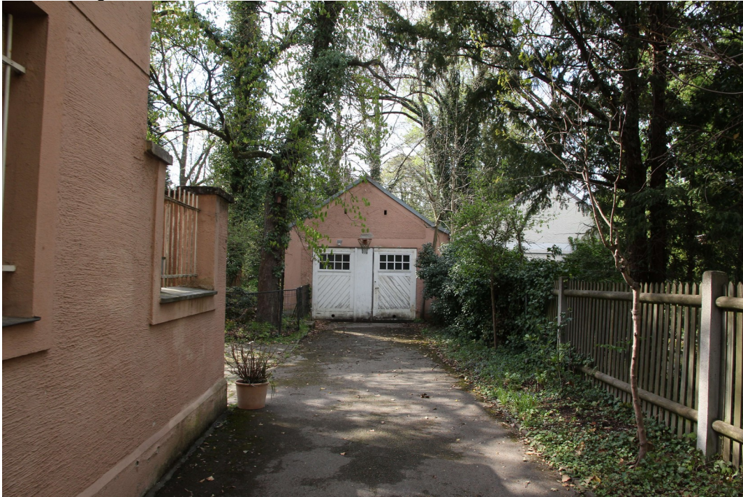
Bild Nr. 19: Garage mit Zufahrt auf dem Grundstück Lachnerstraße 34
