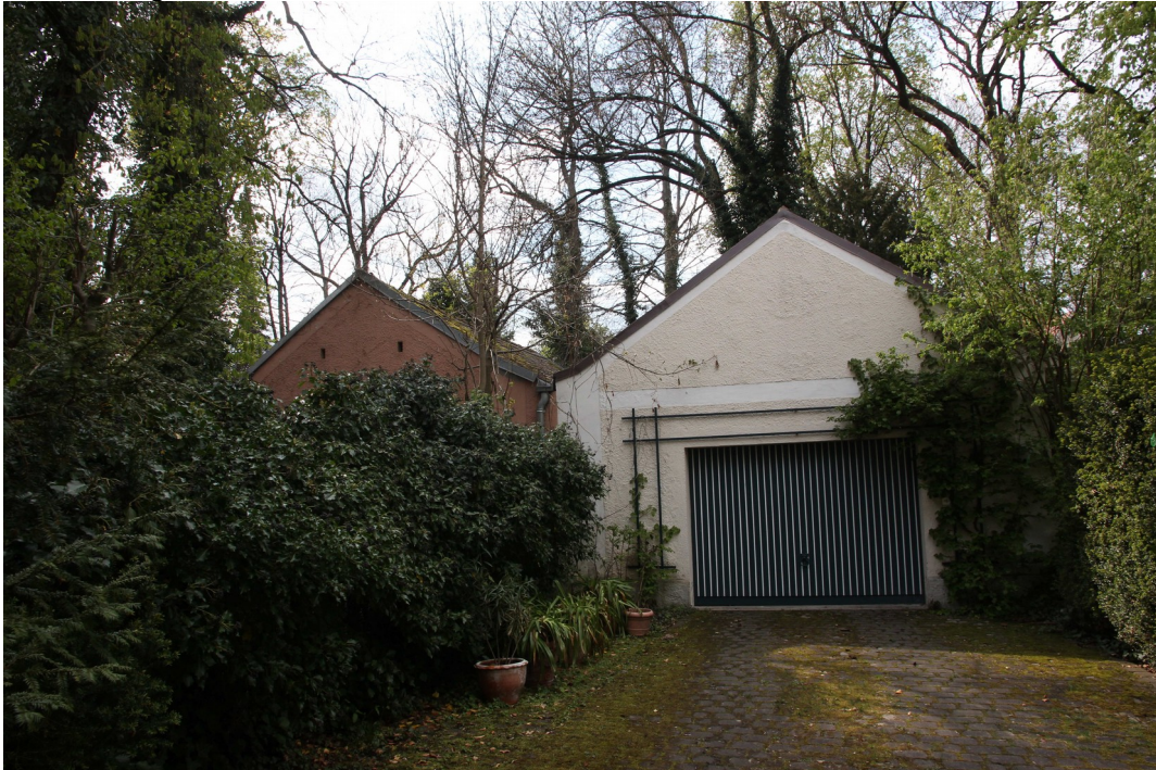
Bild Nr. 17: Garage mit Zufahrt auf dem Grundstück Lachnerstraße 32
