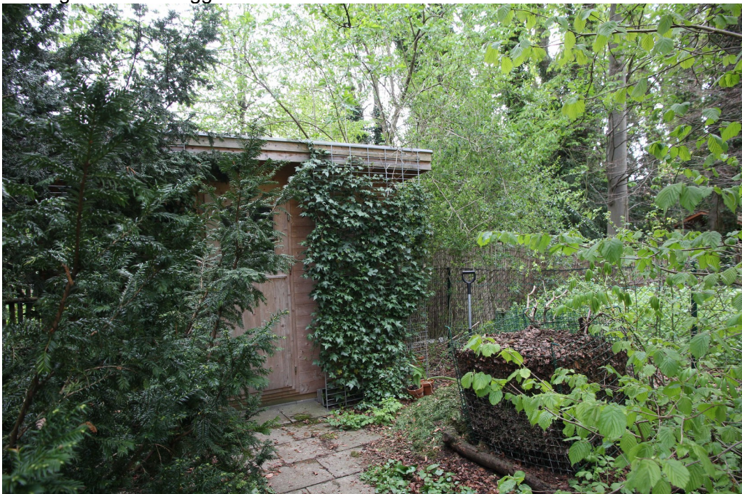
Bild Nr. 4: Der Holzschuppen auf dem Grundstück Flüggenstraße 12 an der Grundstücksgrenze zur Flüggenstraße 10 und Lachnerstraße 28.
