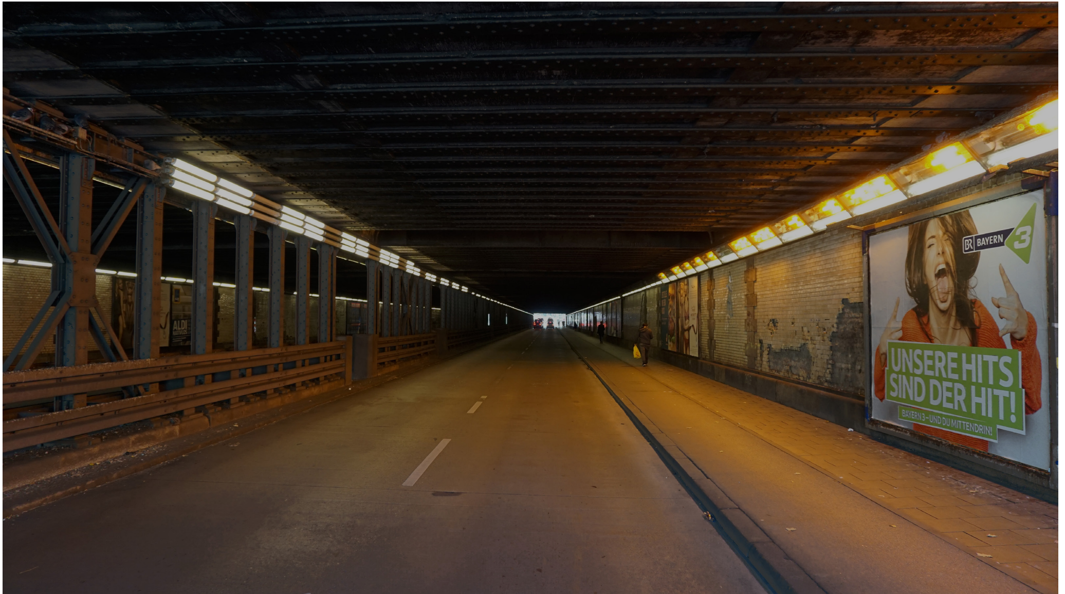
Foto Bestand - Paul-Heysel-Unterführung
