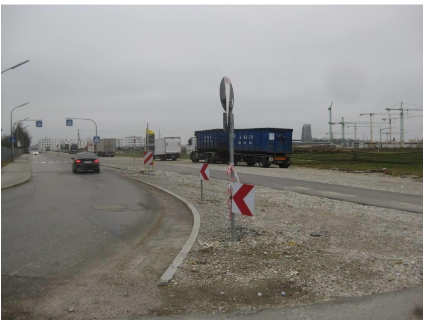
Blick nach Süden zum Fußgängerübergang
