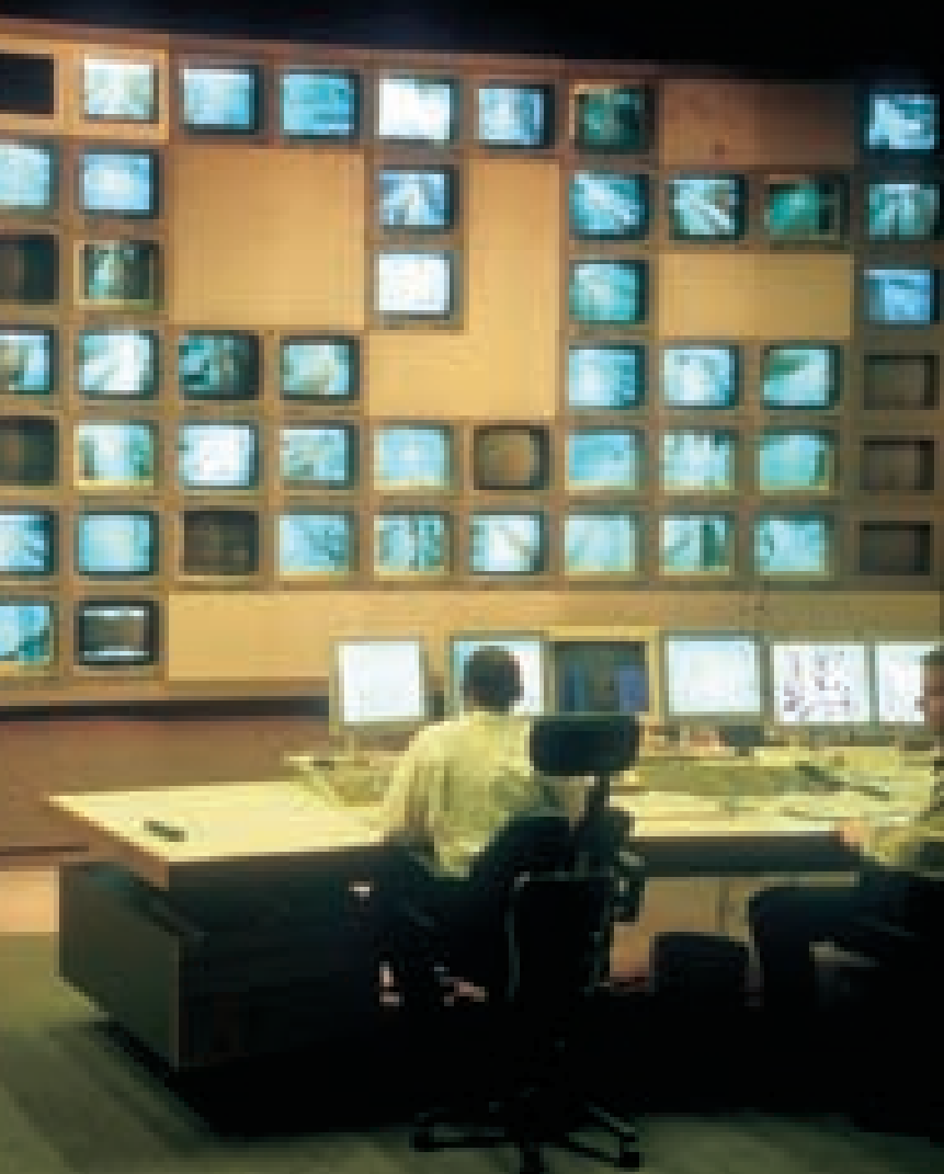
Verkehrszentrale: Die riesige Monitorwand erlaubt den Blick auf strategisch wichtige Verkehrspunkte. Weniger auffällig, aber technisch aufwändiger fallen die MOBINET-Entwicklungen auf den Bildschirmen der Operatoren aus.
