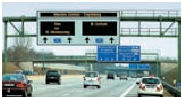
Auf der A8 am Autobahndreieck Eschenried arbeitet die Sektorsteuerung West.
