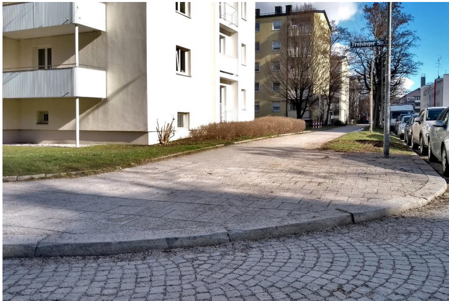
Keine Bordsteinabsenkung an der Kreuzung Isareckstraße / Freisinger Straße
