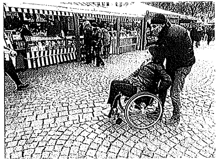
Schwer befahrbares Kleinsteinpflaster
