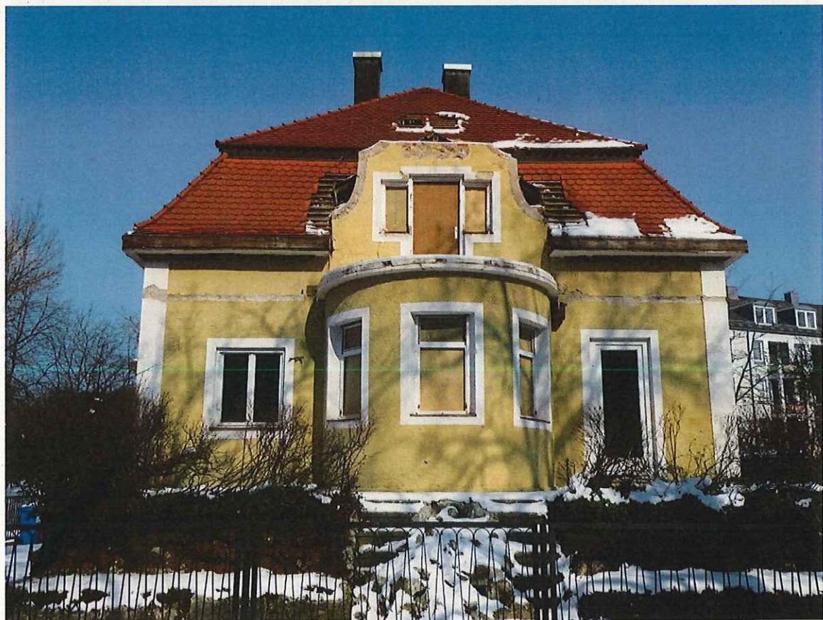
Fotos von Annette Ziller aus dem Buch „Fassadengeschichten“ des Milbertshofener Kulturhausprojektes: oben Sommer 2017, unten Winter 2018
