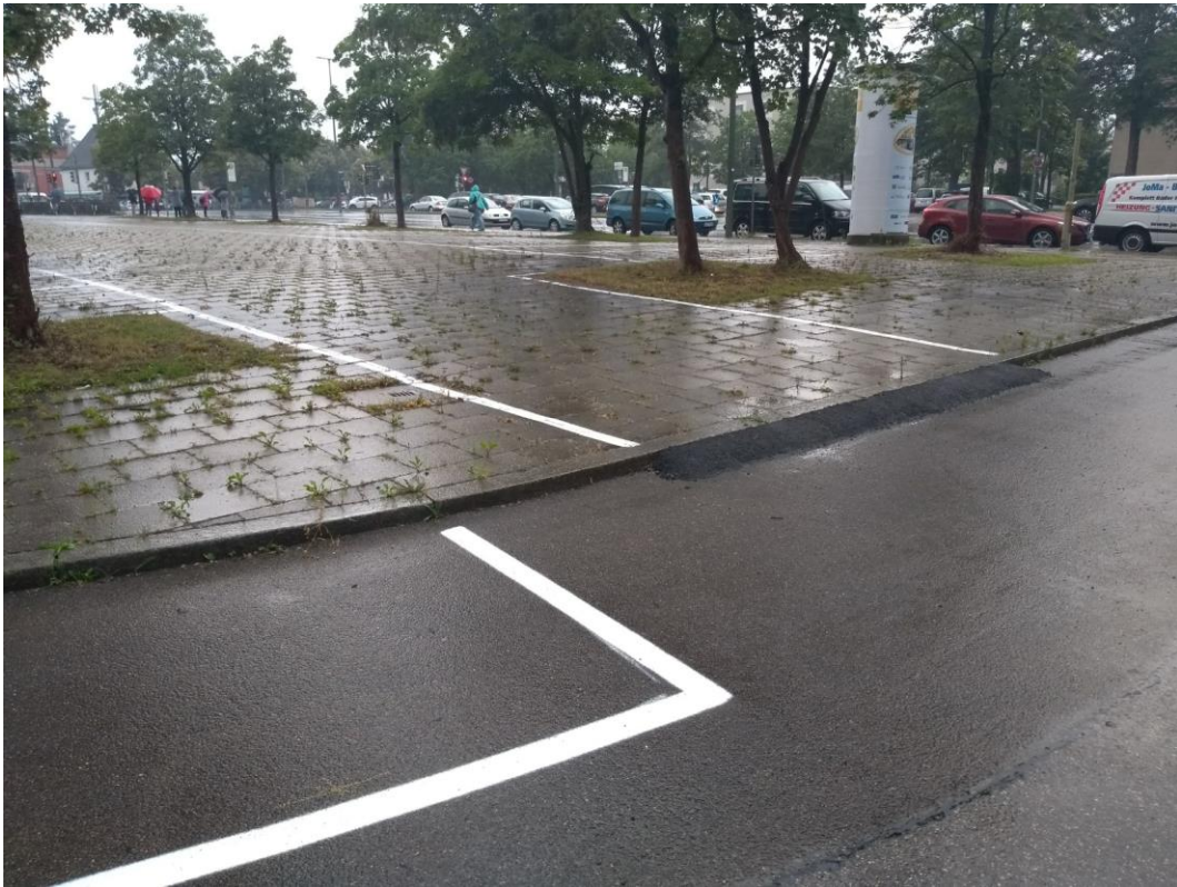
Rampe zu den neuen Parkplätzen.
