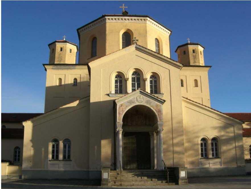
Abb. 2: Nordfriedhof: Portikus, Vorhalle und Aussegnungshalle mit Kuppel heute. Foto: Dirk Heißerer
