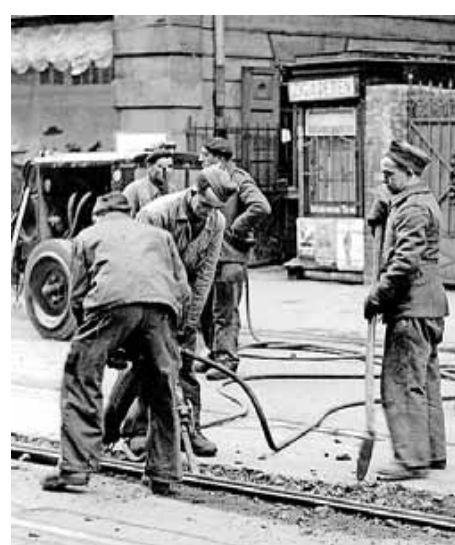
Französische Zwangsarbeiter bei Gleisarbeiten für die Trambahn. FOTO: SZ-PHOTO
