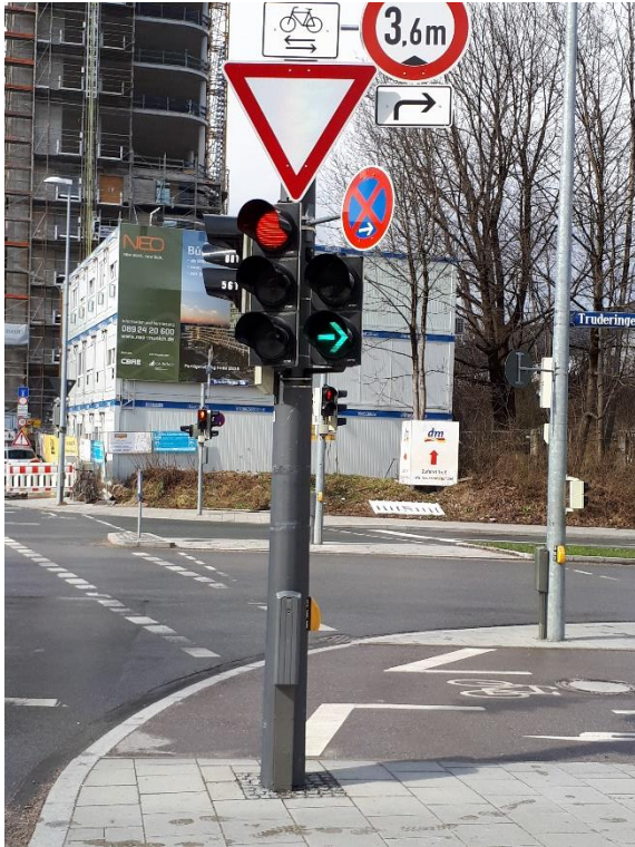
Richtungsampel vorhanden: Truderinger Straße in Tunnel
