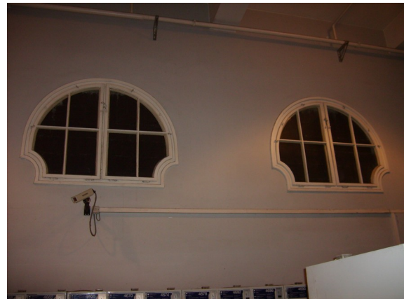
Fenster Südtrakt (Foto: privat)
