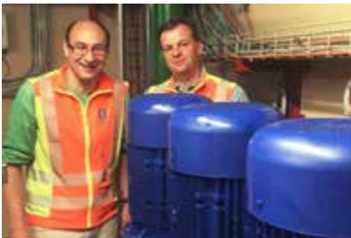
Das Projektteam, Herr Steppert und Herr Hohenleitner, hinter den IE5-Motoren der neuen Betriebswasserpumpstation
