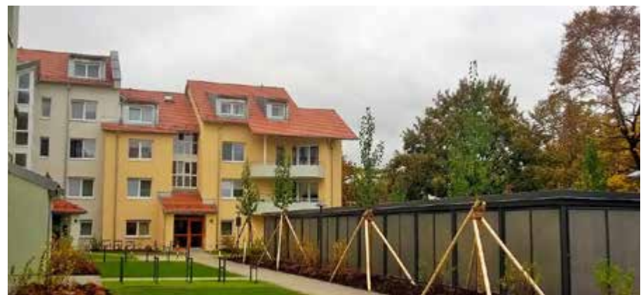
Energetisch sanierte Wohnanlage in Garching
