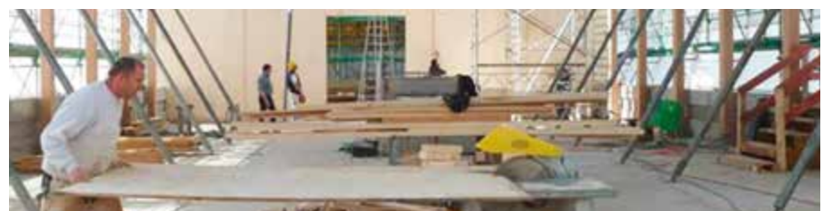
Neubau des Plenarsaals in Holzbauweise
