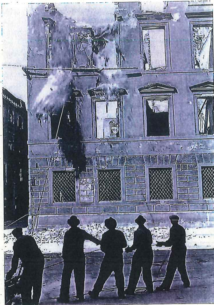
„Abbruch von Teilen der Fassade der Alten Akademie, Ecke Neuhauser- / Kapellenstraße, August 1946“; aus Carmen M. Enss, Münchens geplante Altstadt. Städtebau und Denkmalpflege ab 1944 für den Wiederaufbau, Franz Schiermeier Verlag, Bild Nr. 57, Seite 76
