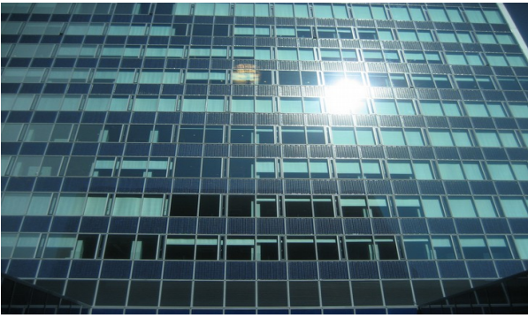
Solarfassade Verwaltungsgebäude Utrecht
