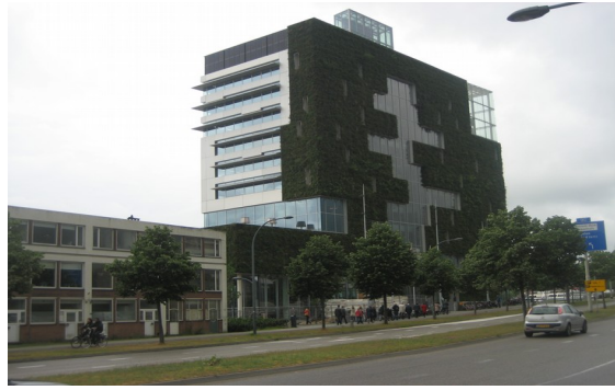
Begrünte Fassade Verwaltungsgebäude in Venlo
