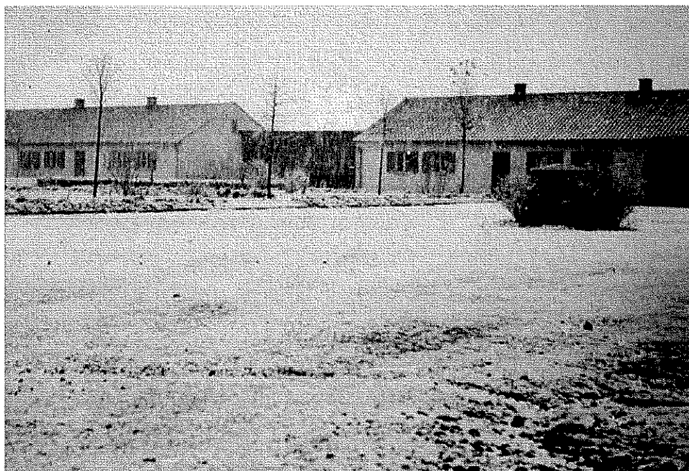
Abb. 55: Aufnahme zwischen 1949 und 1953. Baracke 8 und 7 mit Zwischenbau. Vorne rechts einer der beiden Einmannbunker.
