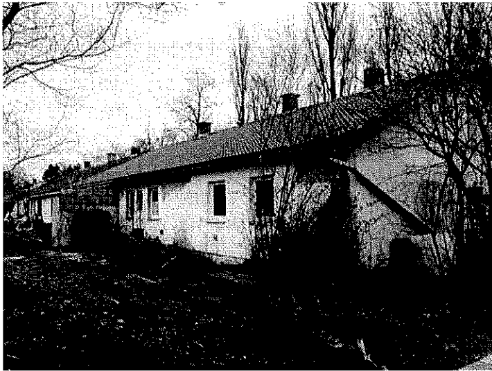
Baracke 8 Nordfassade. Zustand 2012. Aufnahme V. Wilhelm.
