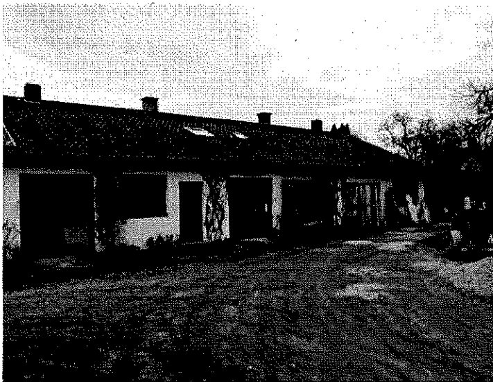
Baracke 8 Südfassade. Zustand 2012. Zustand 2012. Aufnahme V. Wilhelm.
