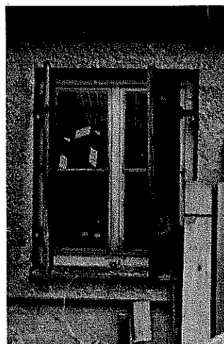
Baracke 8. Detail, bauzeitliches Fenster mit Fensterläden Nordfassade.
