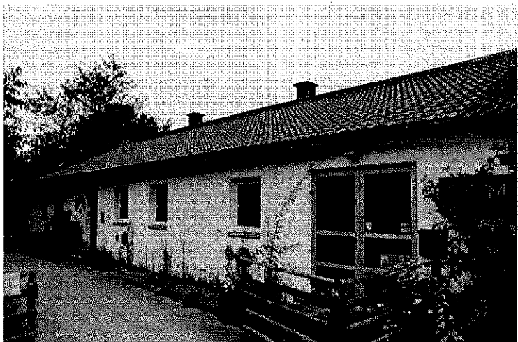
Baracke 8 Südfassade. Neue Dachdeckung mit Frankfurter Pfanne im Bereich der Kinderfarm.
