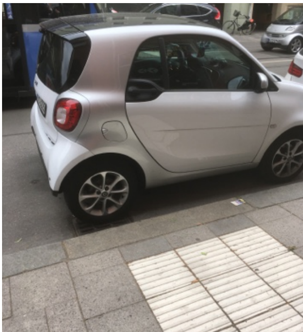
Blockierter Taststreifen
