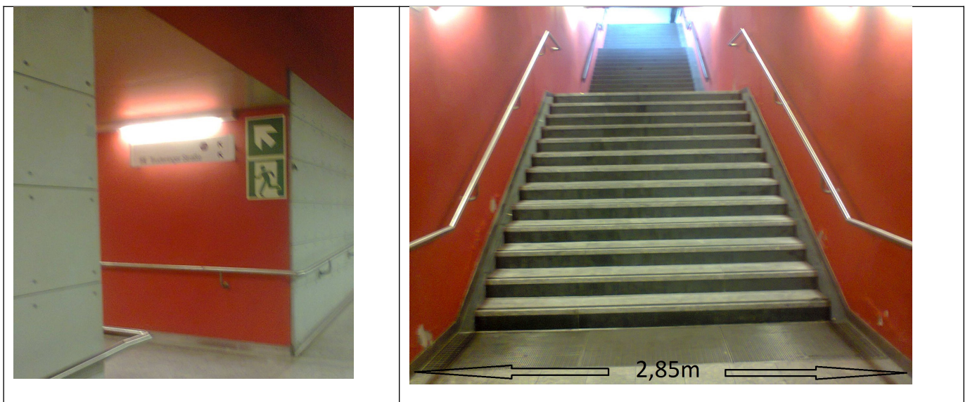
24.08.2019: Blick auf den „alten“ Treppenaufgang vom ZG zum „alten“ S-Bahn-Zugang
