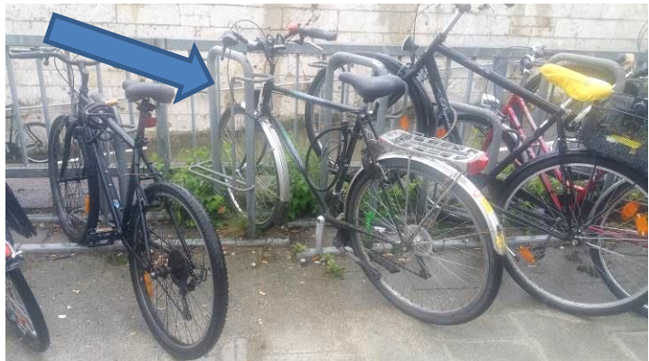
Falsch angebrachte Ständer und derzeit nur mögliche Zuführung des Vorderrades von der Zaunseite (Pfeil)
