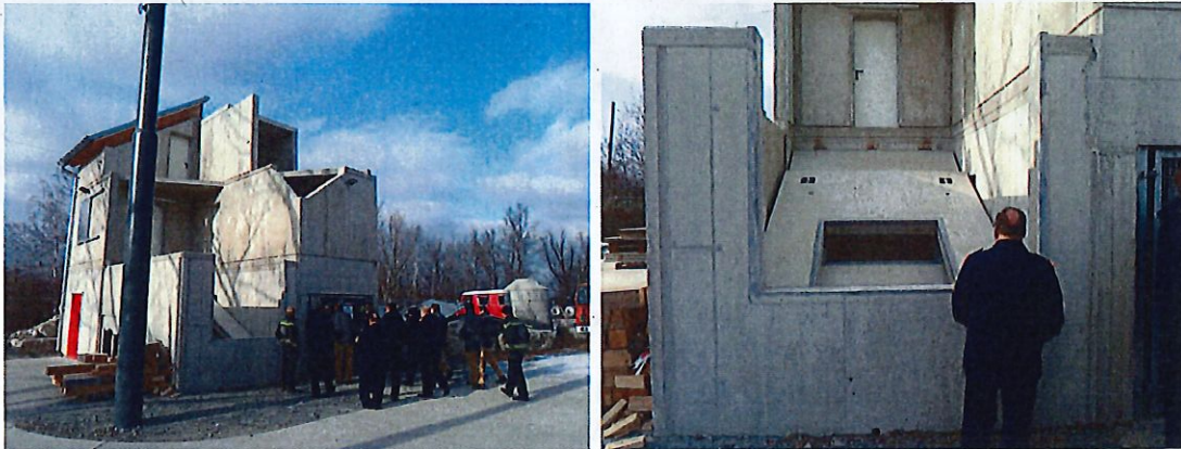
Rohbau/Trümmerhaus der BF Wien
