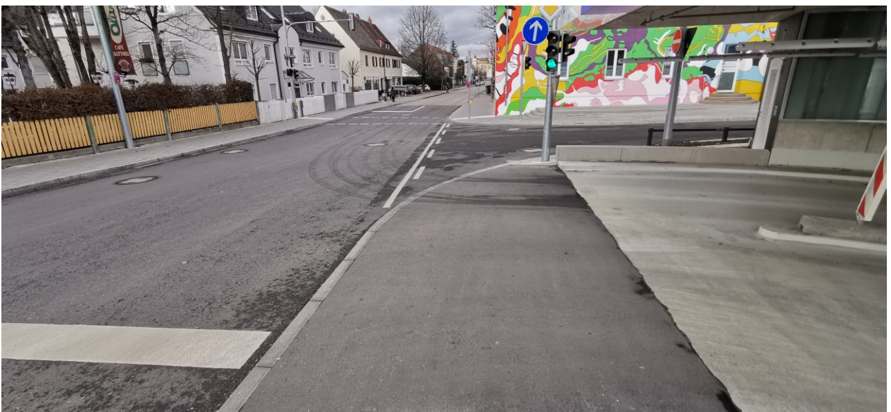
Foto 3: Gehwegplatten bis zur Ampel notwendig
