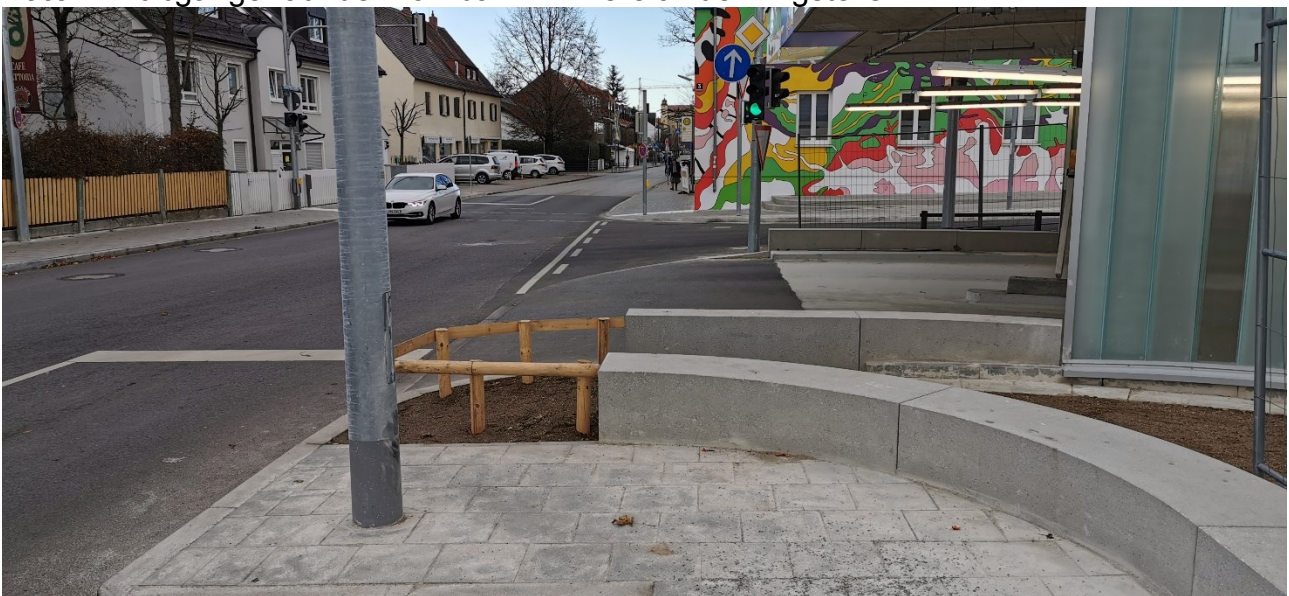
Foto 2: Engstelle zwingt Fußgänger zur Fahrbahnbenutzung
