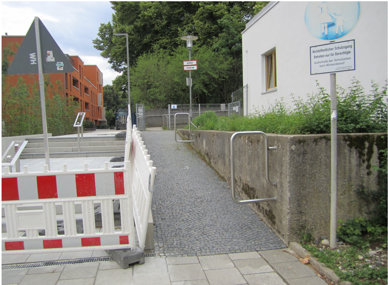
Nichtöffentliche Rampe (Schuleingang) an der Nordseite des Sparkassenhochhauses.
