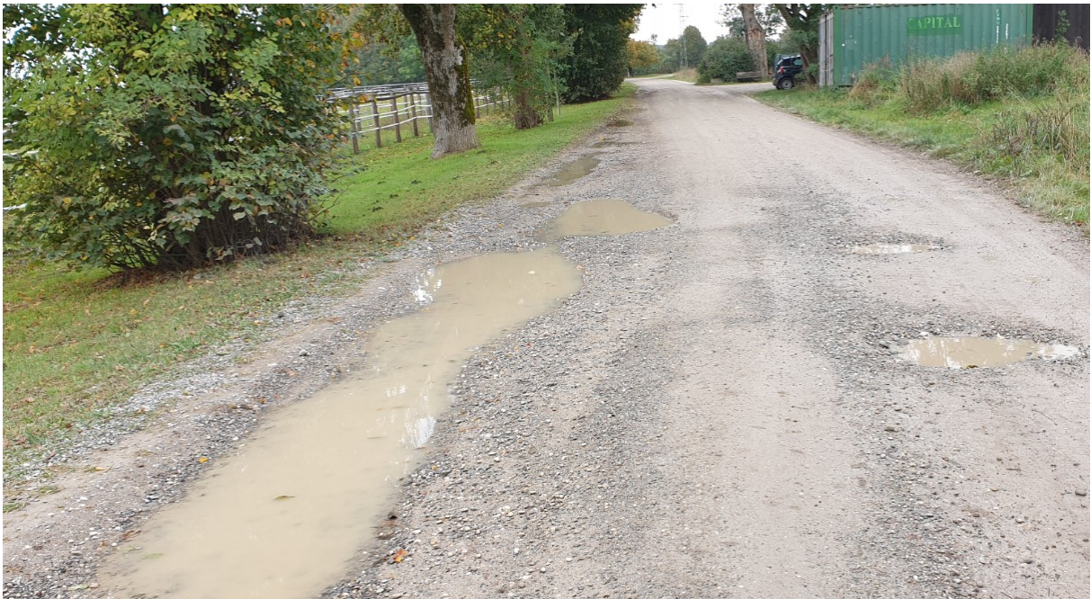
Streifflacher Weg mit Wegschäden
