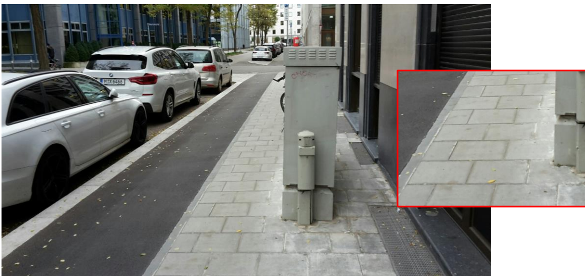
Abb. 3: Engpass vor Türkenstraße 9, Situation im November 2020
