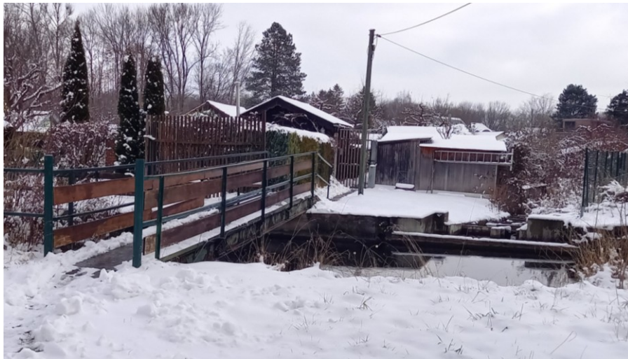
Bild 2 – Brücke über den Garchinger Mühlbach
