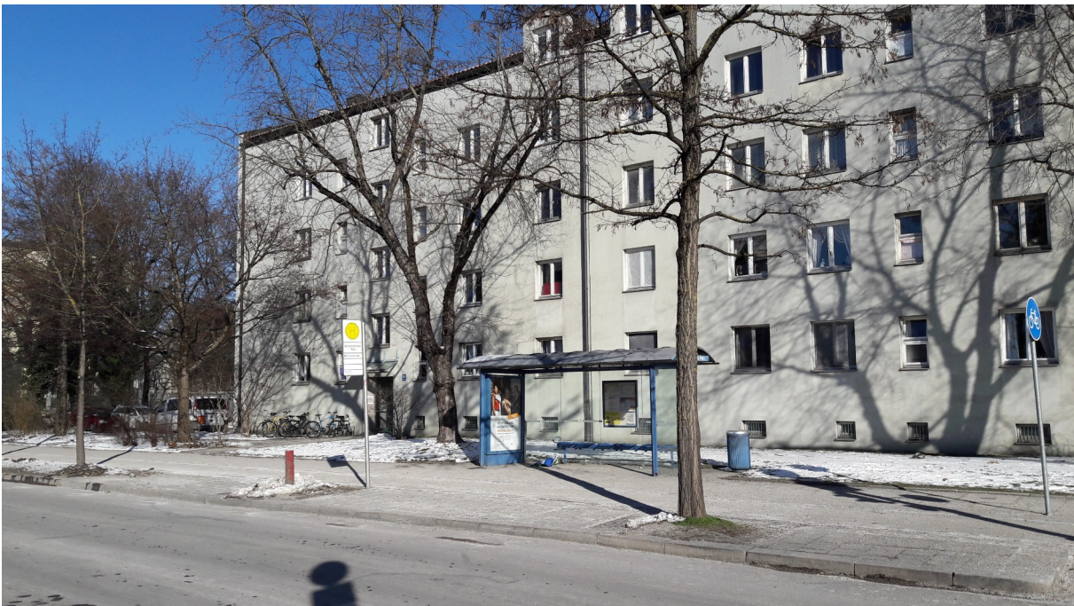
Schaubild 2: Beispielhafte Integration von Alleebäumen an der Bushaltestelle Milbertshofener Platz mittels Baumrost (mittlerer Baum befindet sich in Nachpflanzung)
