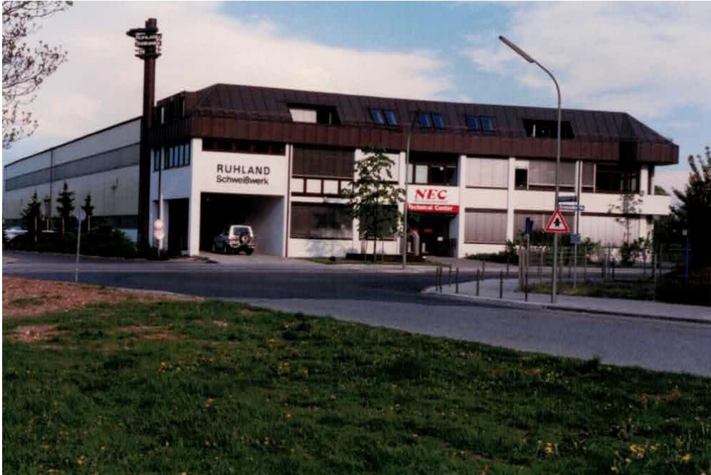
Beispiel Kronstadter Straße: Die Straße wurde – wie auf diesem Foto aus dem Mai 1990 zu erkennen – bereits vor über 30 Jahren hergestellt. Nun wurden Bescheide verschickt.
