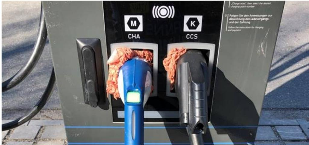
In diesem Fall wurden die Steckvorrichtungen mit Hackfleisch verschmiert, das bis in die Kontakte der Stecker drang. Nachdem diese aus Sicherheitsgründen vom Hersteller verpresst werden, war eine kurzfristige Reparatur vor Ort leider nicht möglich. Für all jene, die sich für ein Elektrofahrzeug entschieden haben und auf eine Ladung im Stadtgebiet angewiesen sind, sind derartige Fälle ein unnötiges Ärgernis.
