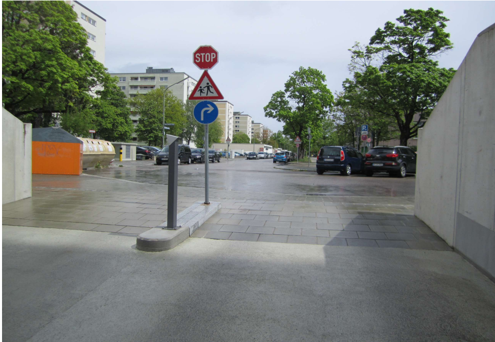
TG-Ausfahrt mit nach rechts sichtbehindernder Mauer
