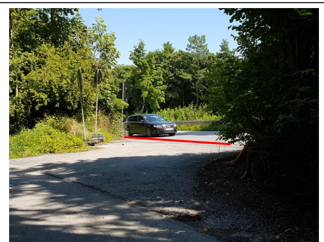
Offene Ein-/Ausfahrt zur Effnerstraße (Auffahrt zur Johanneskirchner Straße) Fehlende Absperrung gekennzeichnet
