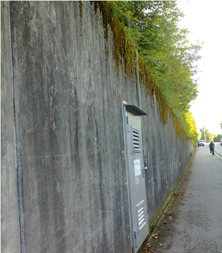
Blick nach Süden, links die Pumpenraum-Türe
