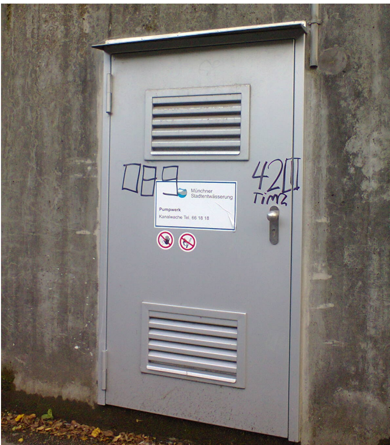
Blick von Westen auf die Pumpenraumtüre
