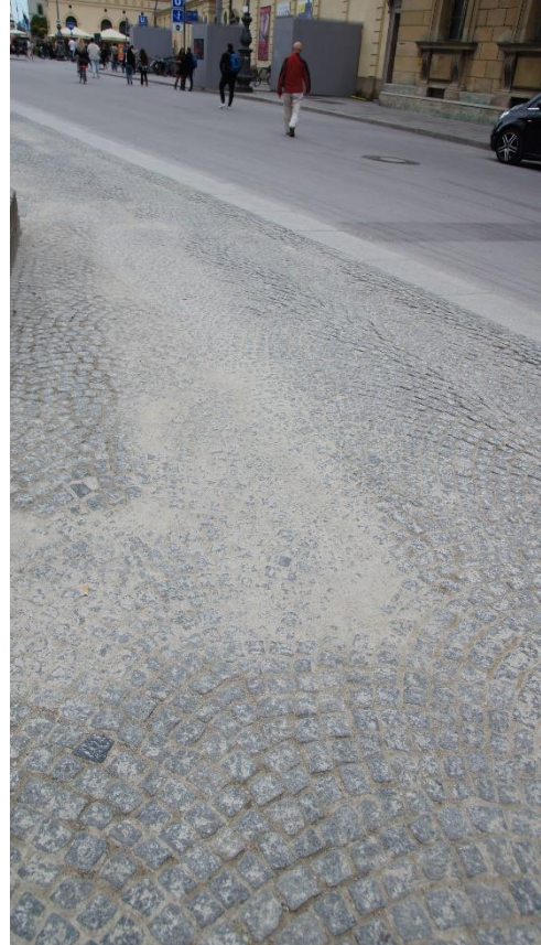
Schäden am Pflaster des denkmalgeschützten Odensplatz
