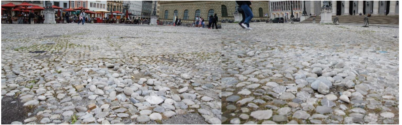
Schäden am Pflaster auf dem Max-Josef-Platz
