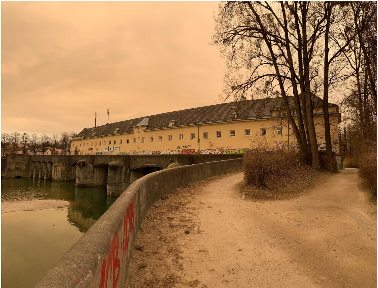
Stauwehr Oberföhring (Nordseite) Foto: Melander Holzapfel, Genehmigung zur Verwendung liegt vor
