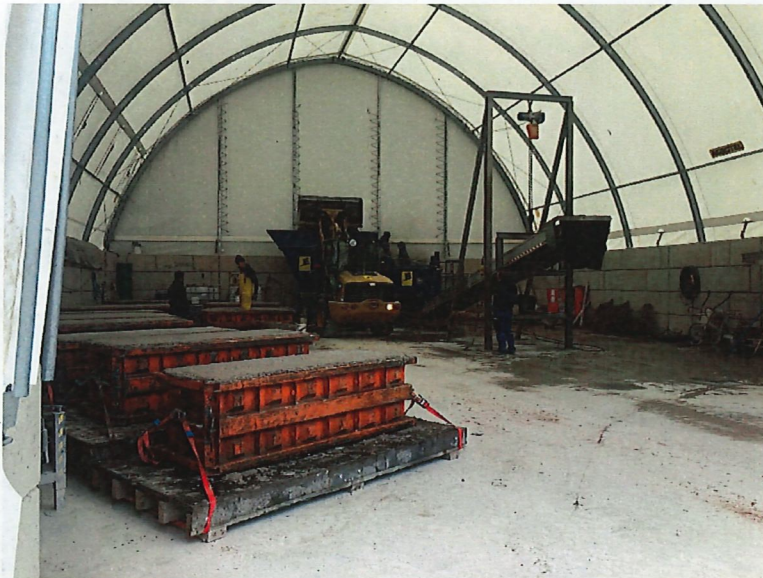
Abbildung 2: Herstellung Blocksteine aus RC-Beton in der Bayernkaserne
