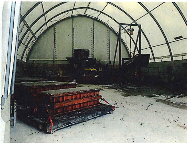
Abbildung 2: Herstellung Blocksteine aus RC-Beton in der Bayernkaserne
