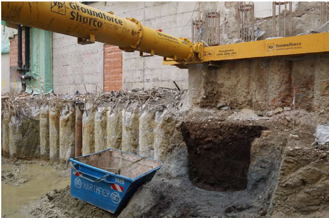
Abb. 10: Eine von 3 geborgenen mittelalterlichen Schachtanlagen in der Weinstraße 7.
