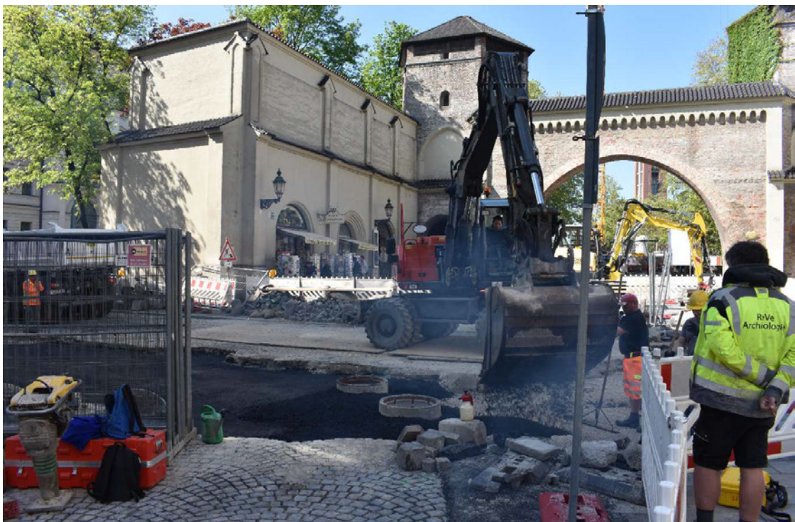
Abb. 13: Arbeiten zur Fernkälte, begleitet durch eine archäologische Fachfirma.
