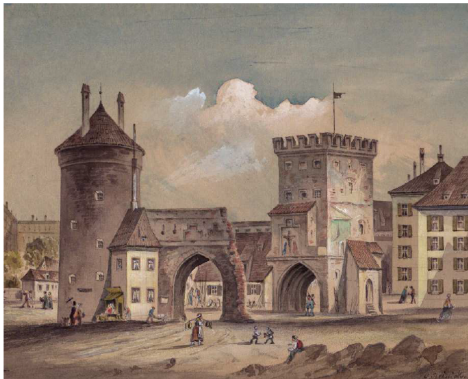
Abb. 6: Das Kosttor während des Abbruchs mit dem massiven Rundturm, Aquarell C. Steinicken um 1885. Stadtarchiv München, HV-BS-A-01-60.
