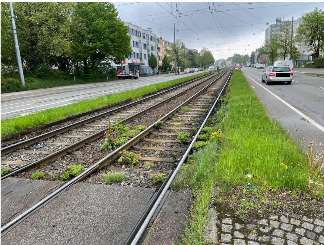
Abb. 2: Gleise Höhe Else-Rosenfeld-Str. als Schottergleis und seitlich mit Rasen statt Blühstreifen
