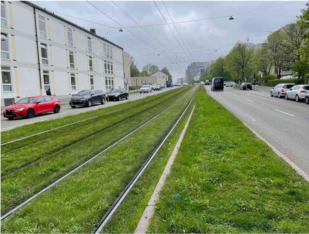
Abb. 1: Gleise Höhe Grundschule als Rasengleise (aber seitlich mit Rasen statt Blühstreifen)
