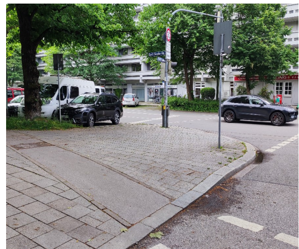
Abbildung 4: Zur Nutzung der Grünsignalanforderung muss der Radweg gequert und Gehweg als Aufstellfläche genutzt werden.
